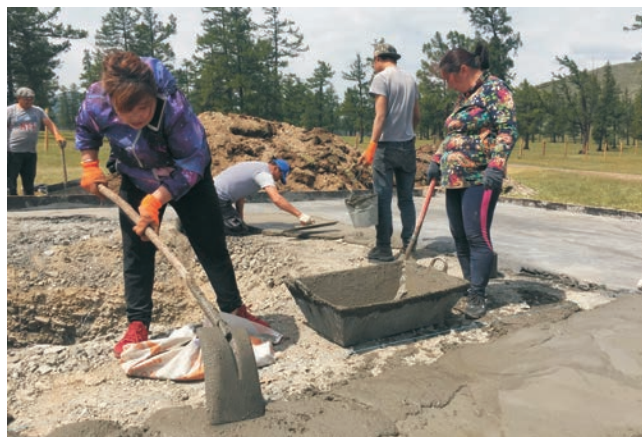
Det første fundament blev udgravet og støbt af foreningens medlemmer. Det måtte senere kasseres pga. dårlig udførelse.
